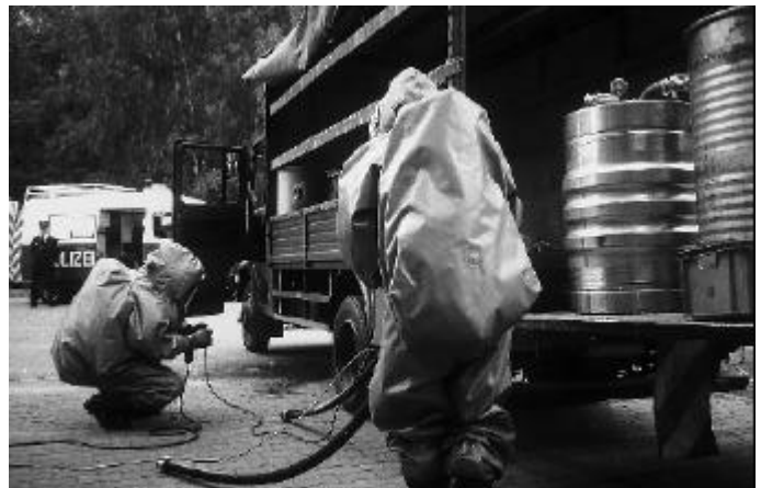
Der TD pumpt eine gefährliche Flüssigkeit aus einem beschädigten Fass um.
