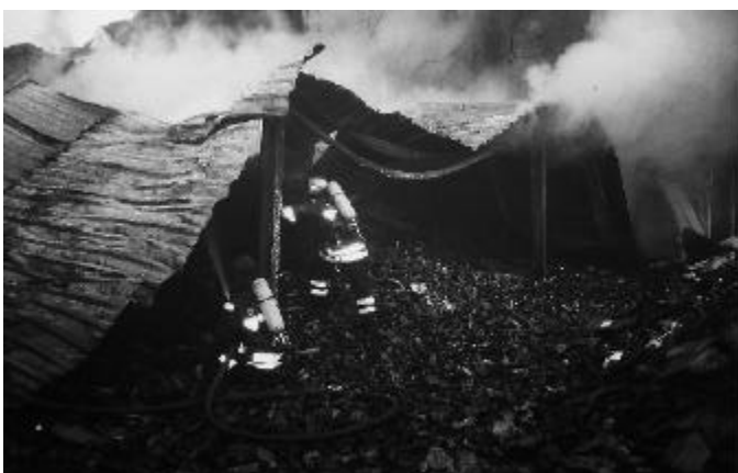
Die starke Hitzeentwicklung verbog Stahlkonstruktionen.
