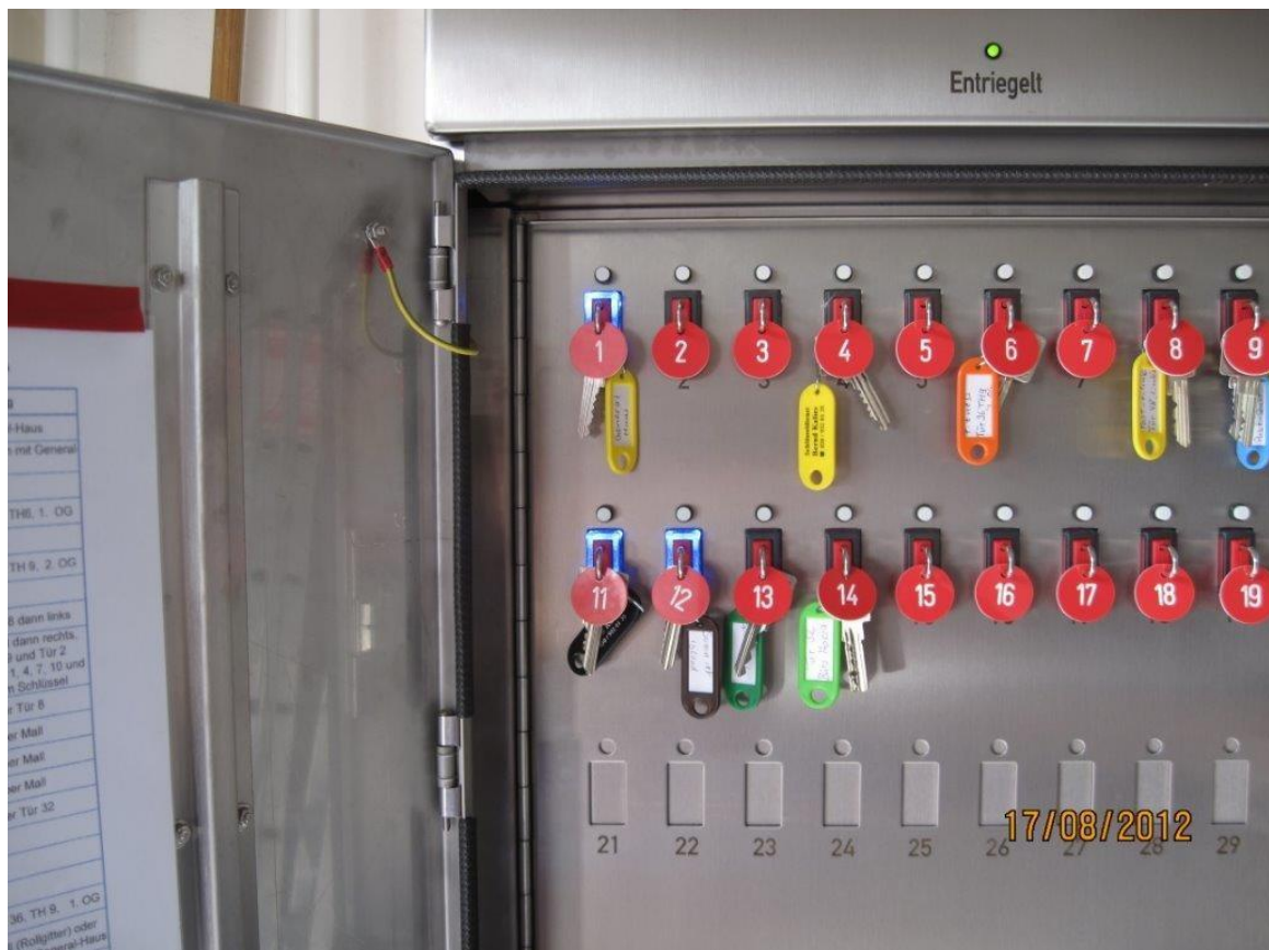
Abbildung 1 Geöffneter FSS mit einzelnen, nummerierten Bereichsschlüsseln und Anzeige der freigegebenen Schlüsselsteckplätze (LED-Leuchte)
