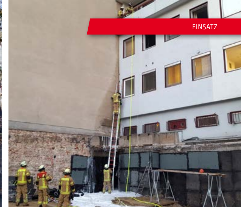
Brand einer Dehnfuge in Neukölln Bild: Berliner Feuerwehr
