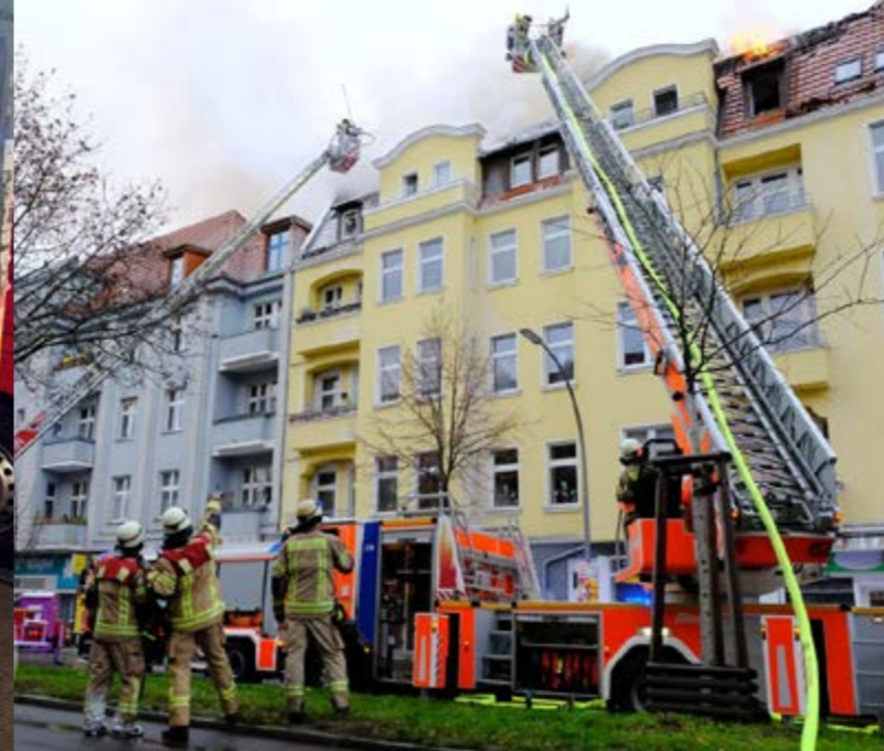
Ausgedehnter Dachstuhlbrand in Lichterfelde Bild: FD Feuerwehr Doku
