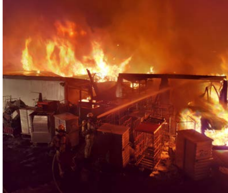
Lagerhallenbrand in Moabit Bild: Sebastian Salzbrenner
