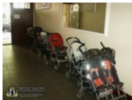
Situation aus dem wahren Leben: Brandlasten im Treppenhaus
