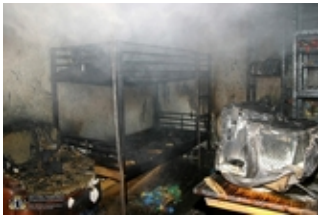
Brandschaden im Zimmer
